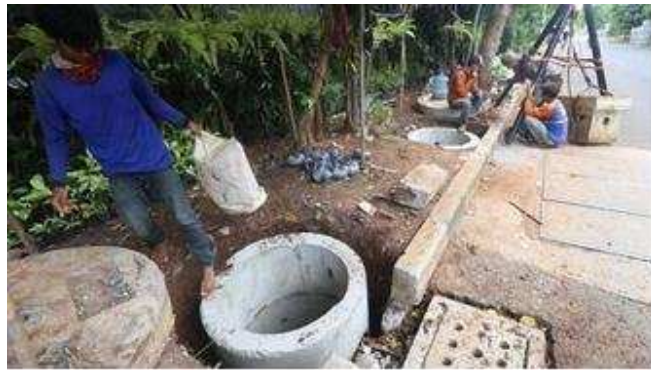
Gambar 1. Proses pembuatan sumur resapan
