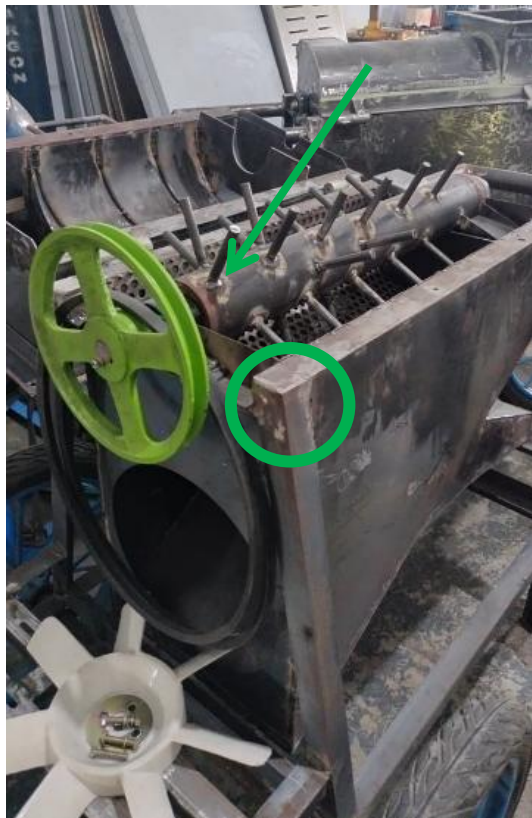
Gambar 3. Korosi pada Besi
