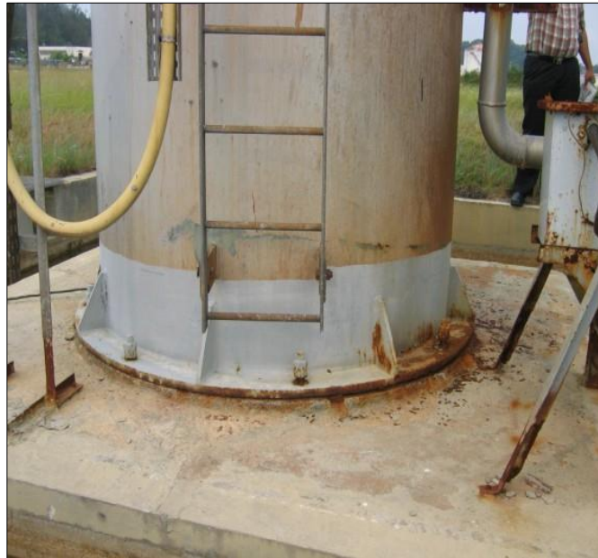
Gambar 2. Korosi pada baut-baut pengikat base plare riser stack (data, 2020)
