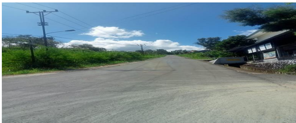
Gambar 2. Jalan yang Sudah Dicor/Beton + Aspal
