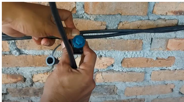
Gambar 1. Penyambungan Conector
