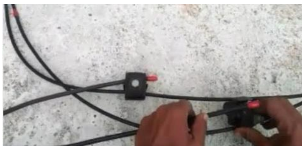
Gambar 2. Penyambungan Conector Langsung
