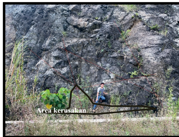
Gambar 3. Foto singkapan tingkat pelapukan II Bendungan Cisokan STA 2.
