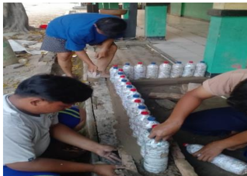
Gambar 4. Membuat pagar Ecobrick
