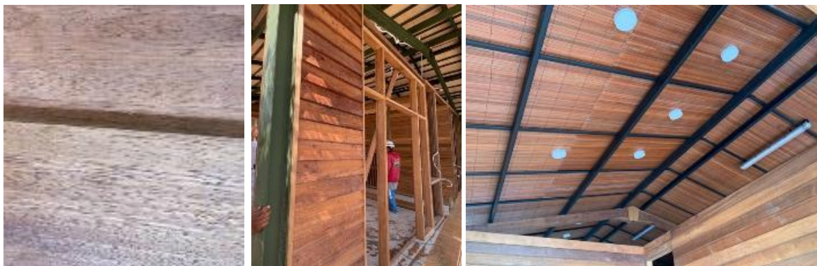
Gambar 8. Dinding eksterior berbentuk tumpang tindih (A), Dinding interior berbentuk seperti lambesering (B), Plafond Krei kayu Bangkirai (C) Sumber: Dokumentasi Pribadi, 2022
