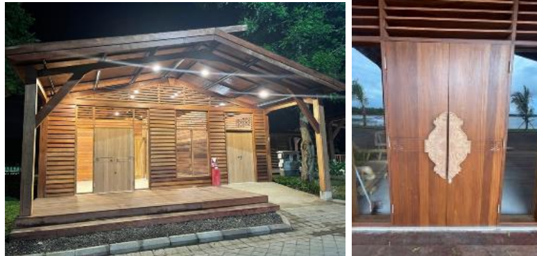
Gambar 3. Tampilan Arsitektur Bali Modern pada Fasad Bangunan dan Ornamen Ukiran pada Pintu Sumber: Dokumentasi Pribadi, 2022
