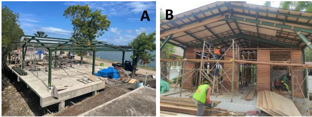
Gambar 7. Penggunaan beton pracetak sebagai pondasi dan baja sebagai struktur utama kolom dan atap bangunan (A) Cover Kayu pada Material Baja (B) Sumber: Dokumentasi Pribadi, 2022
