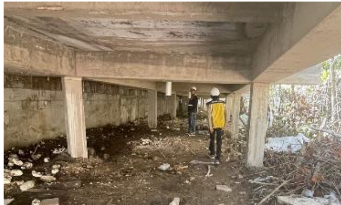
Gambar 5. Penggunaan Beton Pracetak Sebagai Pondasi dan Lantai
