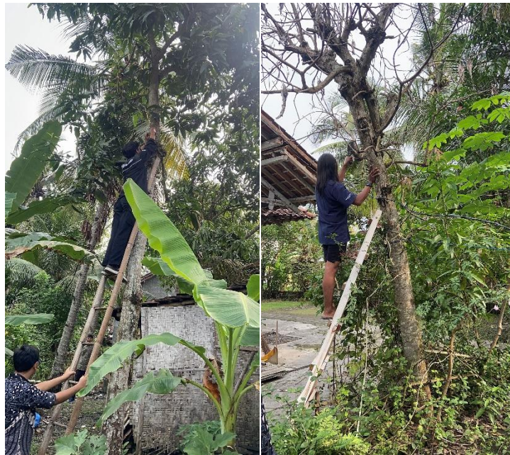
Gambar 3. Instalasi Kabel SR
