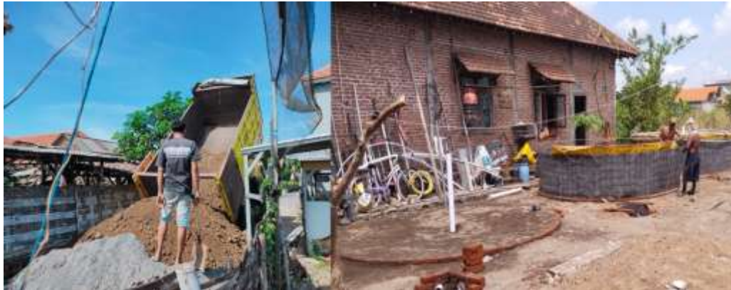
Gambar 3. Penambahan ketinggian dan pembuatan fondasi kolam bundar
