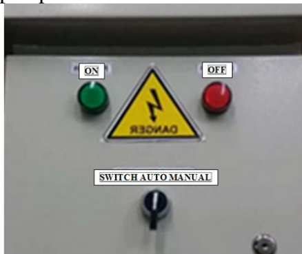
Gambar 4. Panel Kontrol Pompa Tampak Depan
