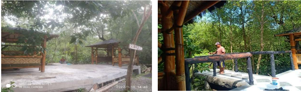
Gambar 4 Dua buah Gazebo yang sudah terpasang
