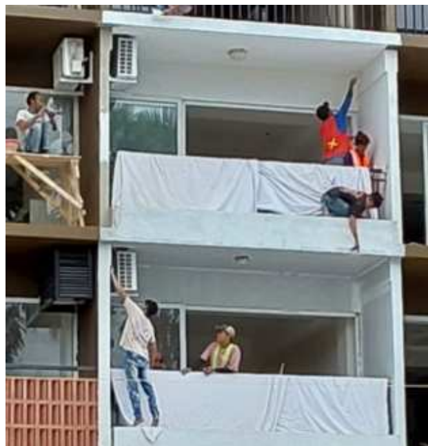
Gambar 4. Proses Keamanan Dalam Reparasi Gedung Bertingkat
