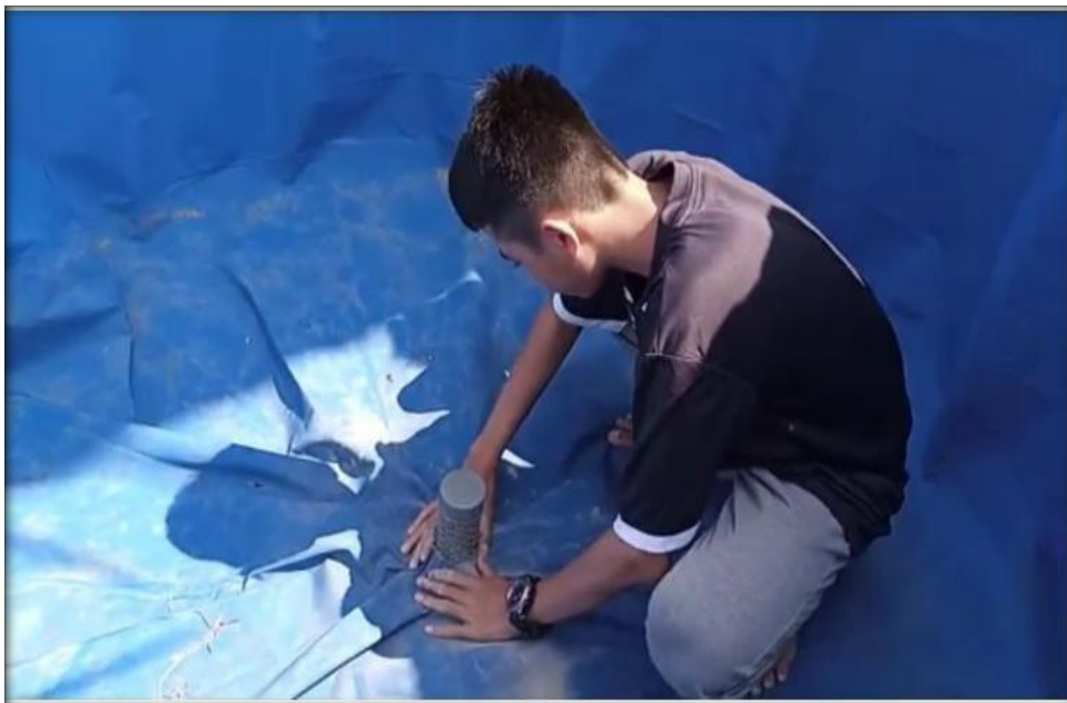
Gambar 4. Pemasangan Pipa Pembuangan Kolam Bundar oleh Siswa.
