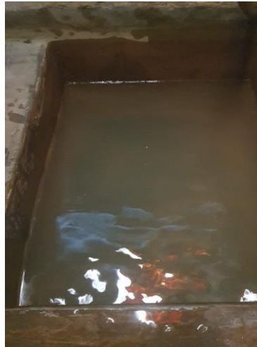
Gambar 1. Kondisi bak penampungan warga
