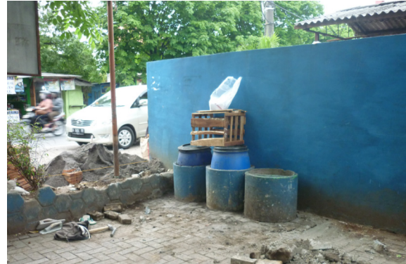
Gambar 9. Renovasi tempat pembuatan kompos
