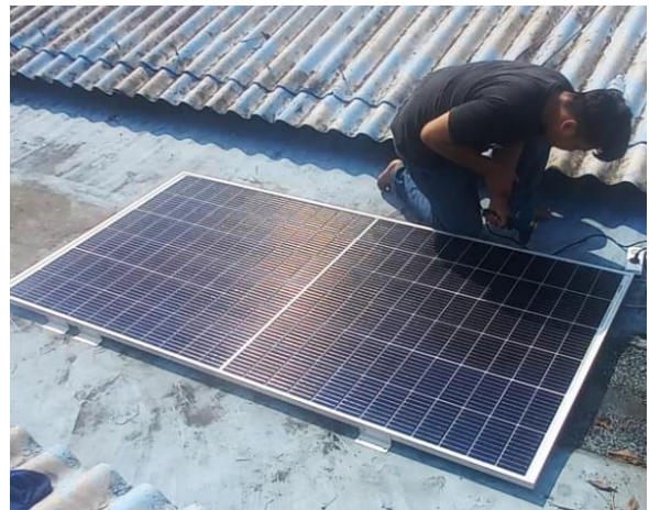
Gambar 4. Pemasangan Panel Surya
