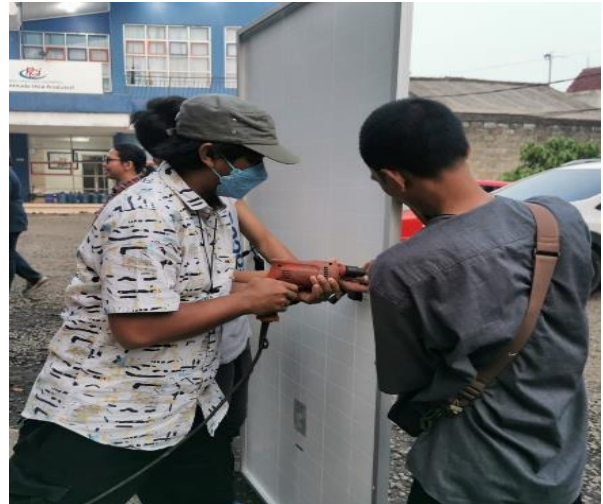
Gambar 3. Pembuatan Lubang di Rangka Aluminium Panel Surya
