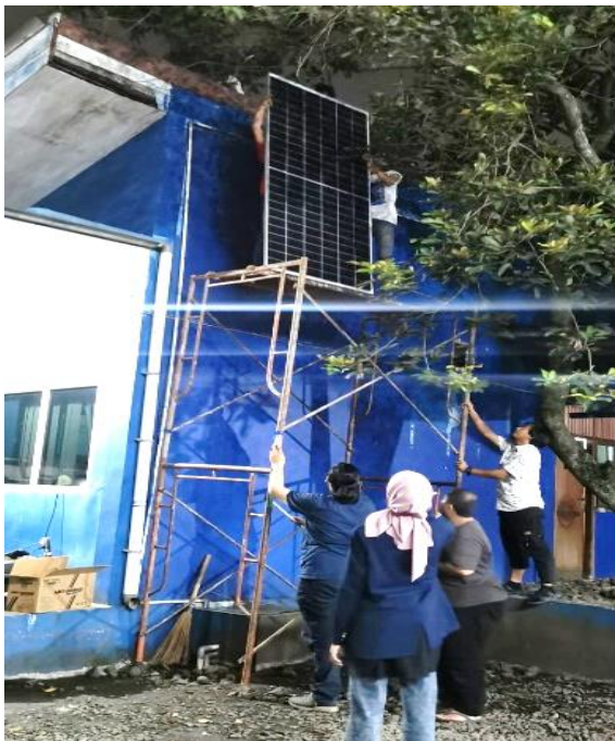
Gambar 2. Meletakkan panel surya ditempat yang dituju
