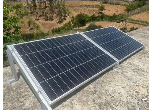
Gambar 19. Panel Surya yang Telah Terpasang
