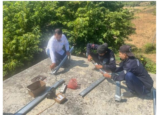
Gambar 18. Pemasangan Rangka Panel Surya
