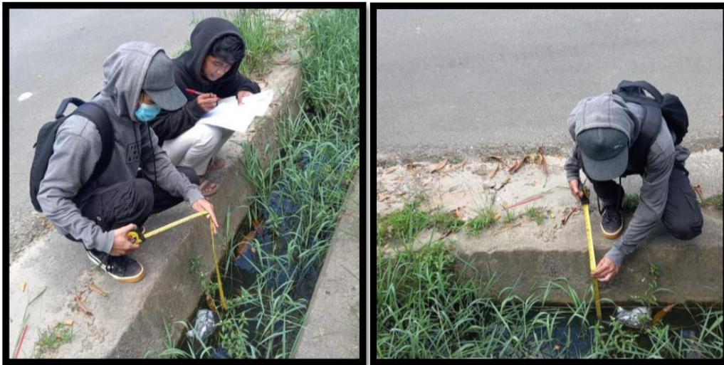
Gambar 3. Kondisi Saluran Eksisting
