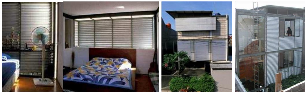
Gambar 9. Metal lembaran bergelombang dan bata putih, mendominasi dinding luar dan kaca dibagian belakang khususnya area tangga
