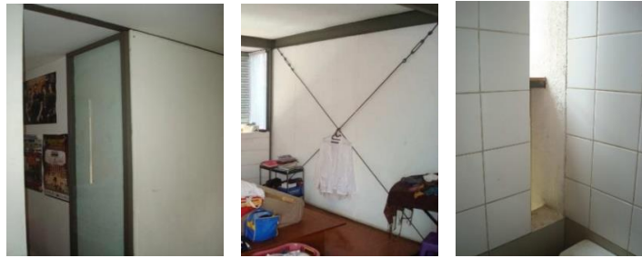
Gambar 8. Pemisah ruang dalam menggunakan kayu lapis 0,6 cm dgn rangka besi 40x40 mm, dicat emulsi. Kecuali dinding kamar mandi, bata putih lapis keramik
