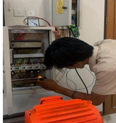
Gambar 5. Setting Trip Arus Lebih Pada TOR
