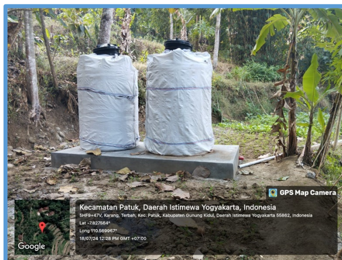
Gambar 7. Penempatan tampungan air (Sumber : Dokumentasi Penulis, 2024)
