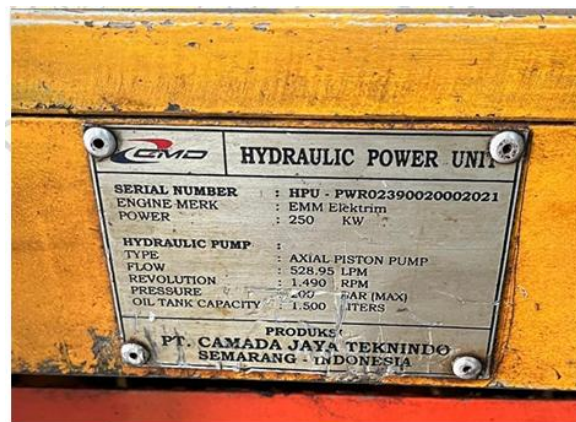
Sumber: Dokumentasi Pribadi, 2025 Gambar 6 Spesifikasi Pompa di Rumah Pompa Waru
