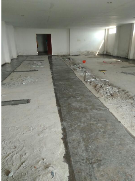
Gambar 2: pelapisan FRP dengan polyester.
