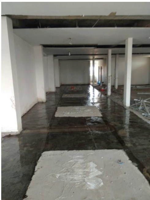
Gambar3: pelapisan daerah plat tumpuan sudah selesai.
