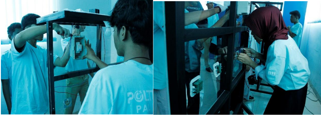
Gambar 5. Peserta sedang Praktik Instalasi Jaringan Listrik
