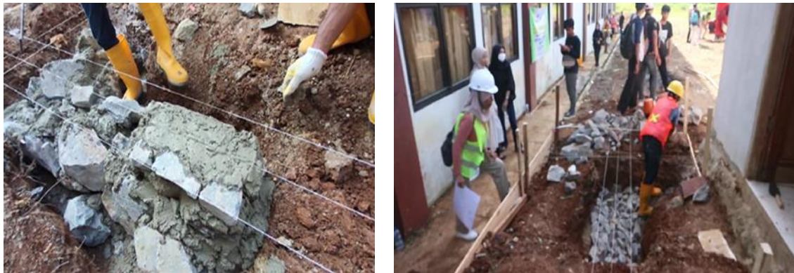
Gambar 5. Penyiapan Lubang Pondasi dan Pemasangan Batu Belah
