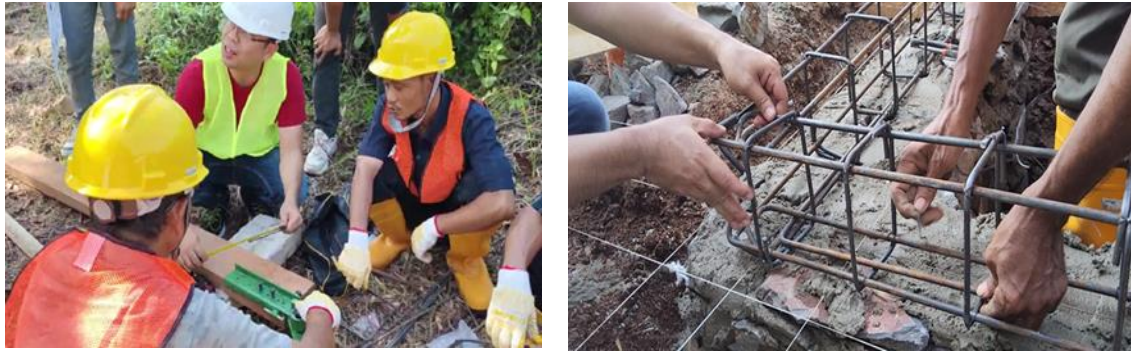
Gambar 6. Pabrikasi Pembesian Sloof dan Perakitan Besi
