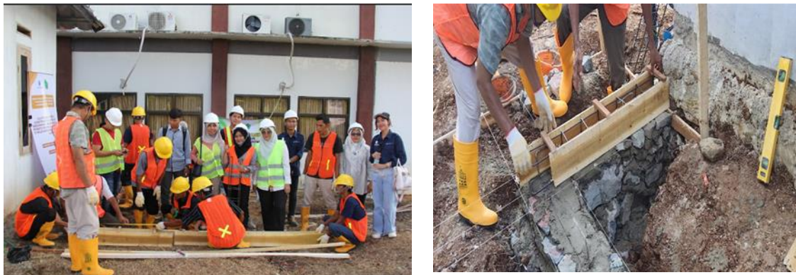
Gambar 7. Pabrikasi Bakesting dan Pemasangannya
