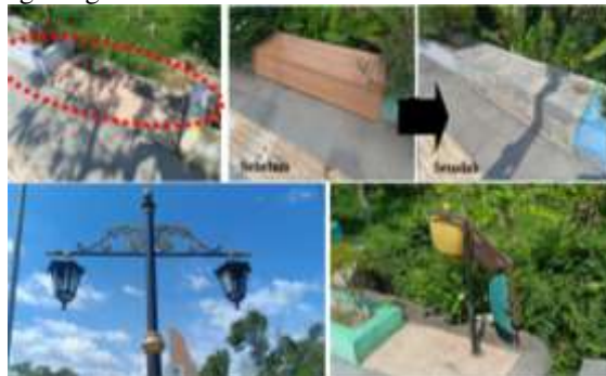
Gambar 19. Bangku taman dan lapisannya hilang (atas), kaca lampu yang pecah (kiri bawah), tempat sampah dan besinya yang rusak (bawah kanan) .
