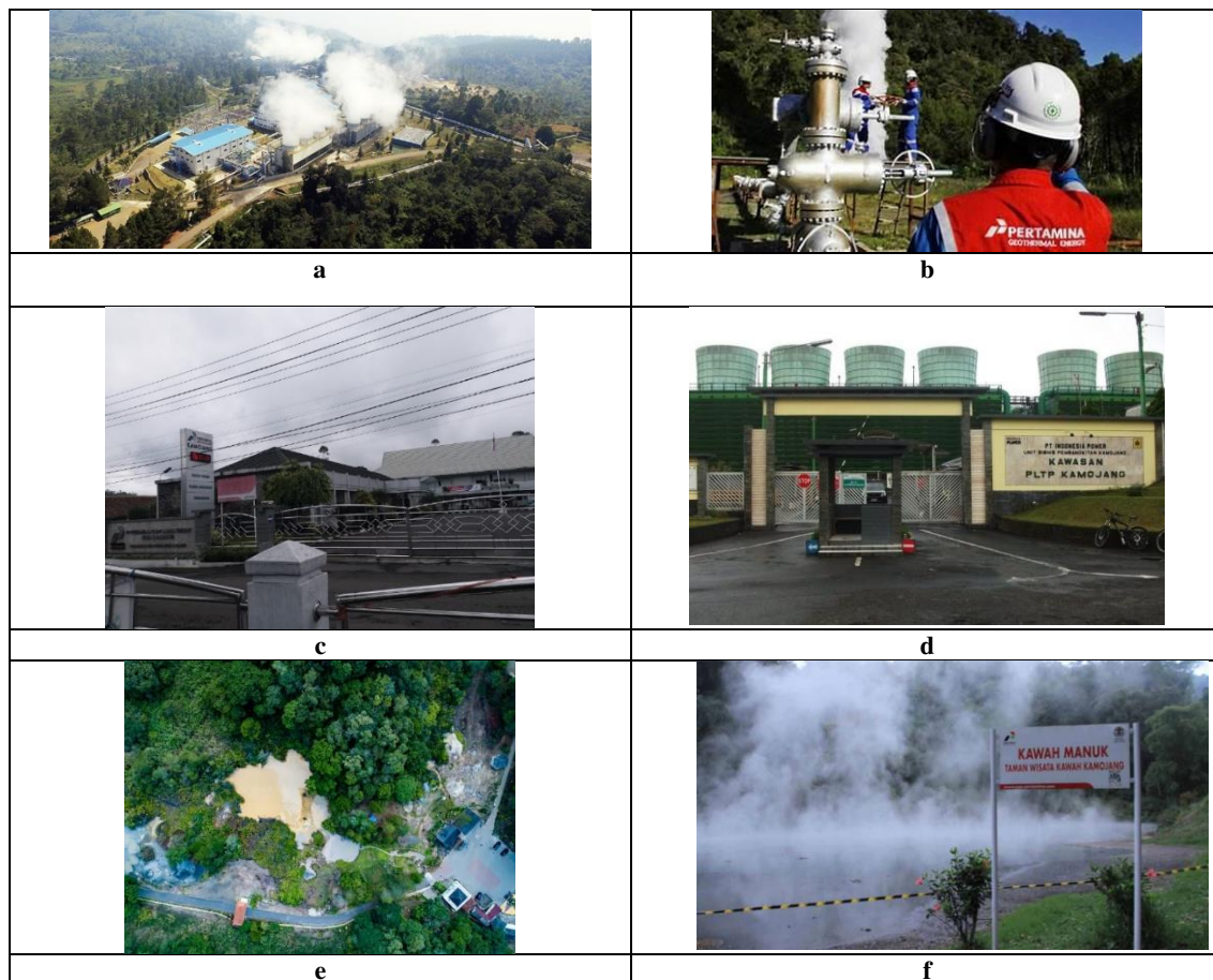
Gambar 7. Pembangkit Listrik Tenaga Panas Bumi: a. Kamojang Geothermal Power Plant Complex [17], b. PLTP 3 MW Kamojang – BBPT [18], c. PT. PGE Area Kamojang [19], d. PLTP Kamojang [20], Manifestasi Panas Bumi: e. Kawah Kamojang [21], f. Kawah Manuk [22].
