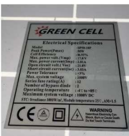
Sumber : (Dokumentasi Penulis, 2024) Gambar 8. Jenis Panel Surya Yang Terpasang
