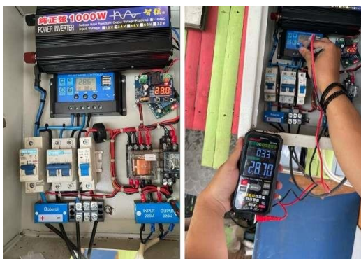
Sumber : (Dokumentasi Penulis, 2024) Gambar 9. Penyambungan dan Pengujian
