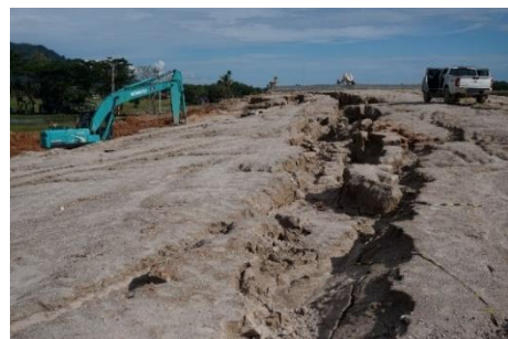
Gambar 2. Dokumentasi Keruntuhan Lereng STA 4+400 – 4+600
