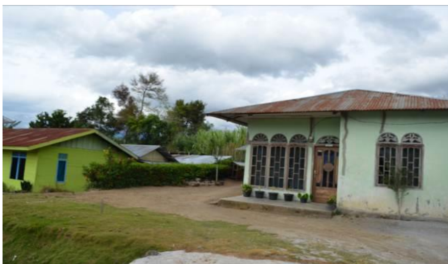
Gambar 4 Rumah Rusak Ringan
