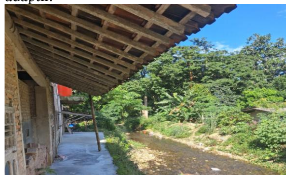
Gambar 1: Observasi langsung Dusun B yang terdampak banjir
