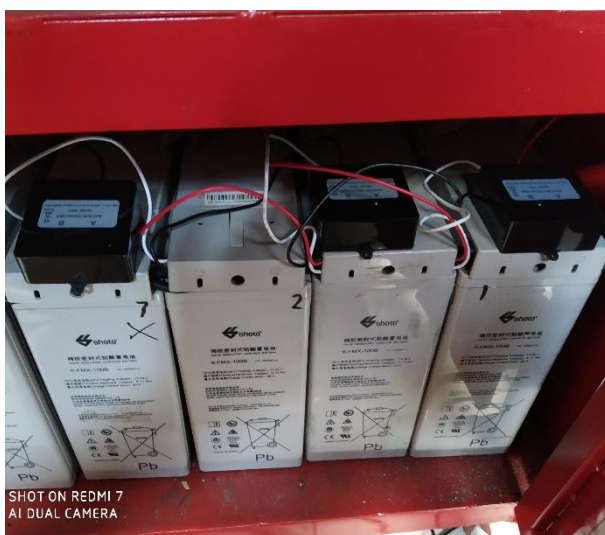
Gambar 5. Banttery VRLA dengan penyeimbang tegangan
