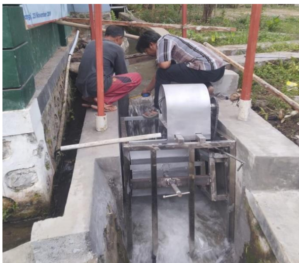
Gambar 3. Pembangkit Listrik Tenaga Piko Hydro
