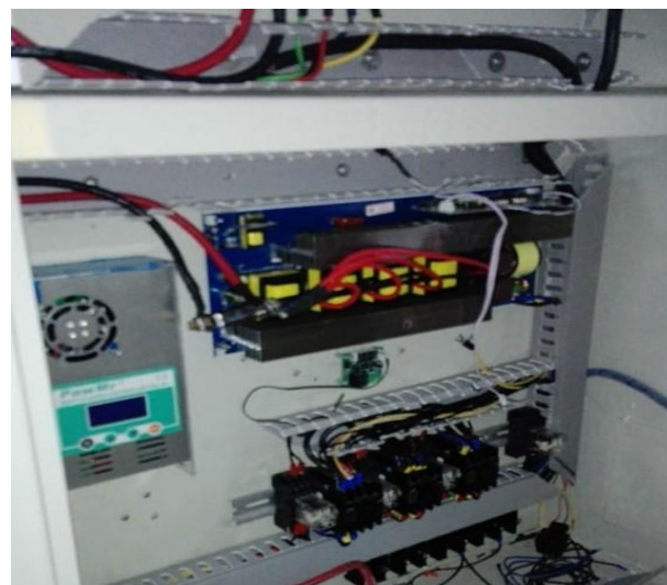
Gambar 4. Sistem kontrol dengan MPPT dan Inverter
