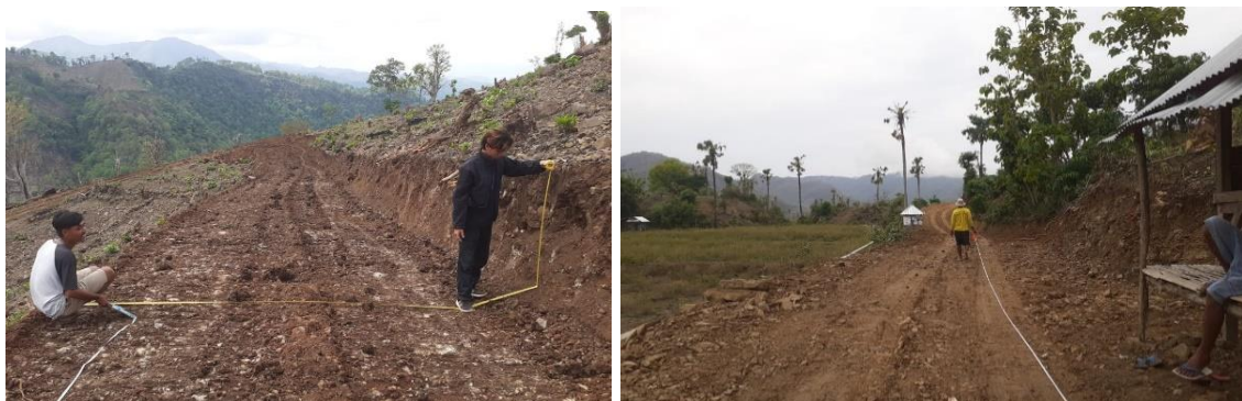
Gambar 11. Survey dan Pengukuran Jalan Long Section dan Cross Section
