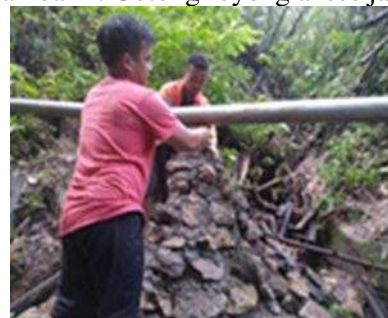
Gambar 2. Perbaikan pipa air
