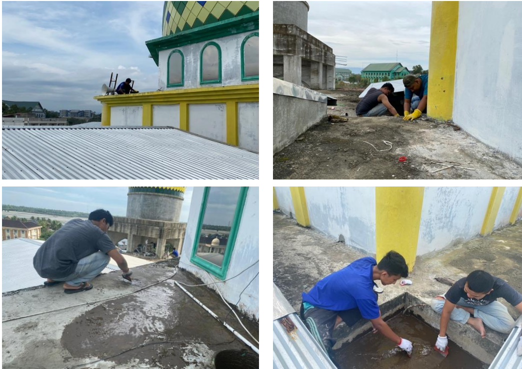
Gambar 4. Pengaplikasian waterproofing coating berbasis geopolimer pada permukaan plat dak
