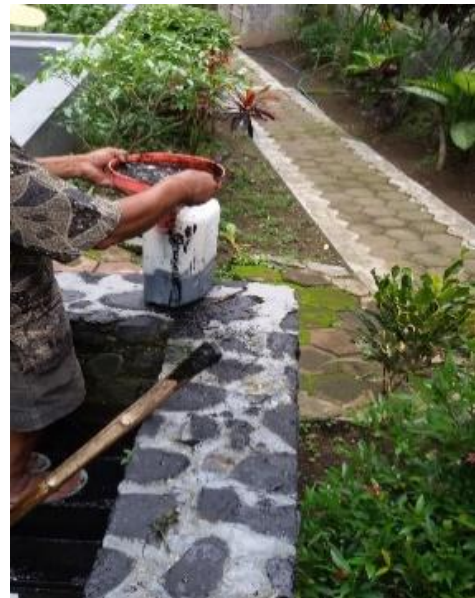
Gambar 1.1:Kondisi Septic tank Komunal atau MCK Terpadu di Tlogomas 120 KK (Gambar tahun 2016)
