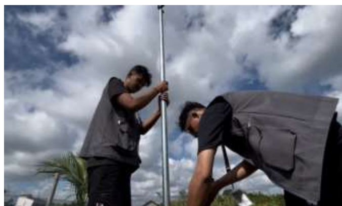
Gambar 4. Pemasangan Lampu Tenaga Surya di Lokasi Pemancingan Kelurahan Sesumpu
