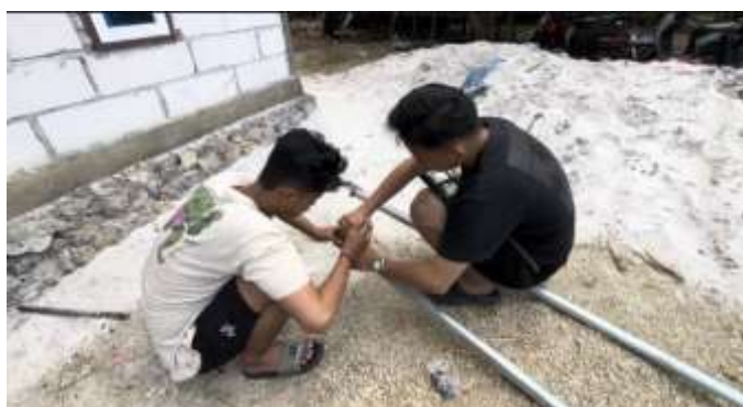
Gambar 3. Persiapan Pemasangan Tiang Besi Penyangga Lampu Tenaga Surya
