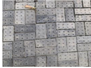
Gambar 4. Paving Block Dari Sampah Plastik
