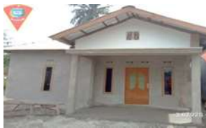
Gambar 3. Kondisi atap, struktur, dan dinding
