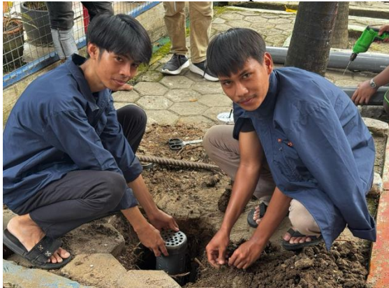
Gambar 4 Pembuatan Biopori
