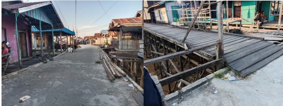
Gambar 3. Kondisi rumah dan jalan di Kelurahan Pahandut Seberang Sumber : Lumbantobing, J. E, dkk, 2022
