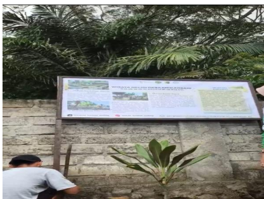
Gamabr 9: Pemasangan papan informasi
