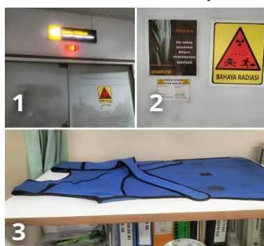
Gambar 1. Lampu Tanda Bahaya Radiasi (1), Tanda Peringatan Bahaya Radiasi Dipasang pada Pintu Ruang (2), dan Apron Pb (3)
