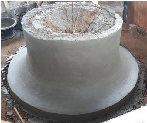
Gambar 13. Penghalusan permukaan Profil
