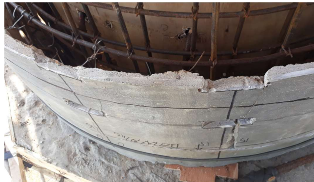
Gambar 18. Kuncian profil beton trumpet di posisinya pada tulangan dinding
