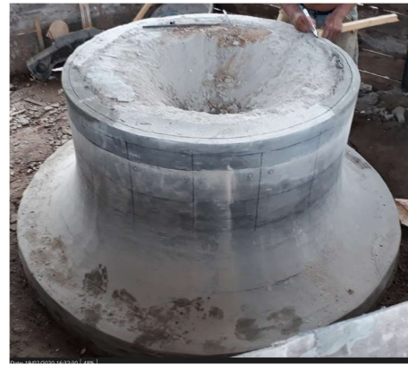
Gambar 14. Membuat jalur pembelahan dan kode sambungan
