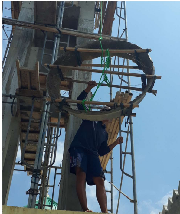
Gambar 17. Proses pengangkatan profil trumpet
