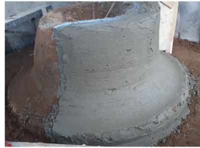
Gambar 12. Pembentukan kountur
