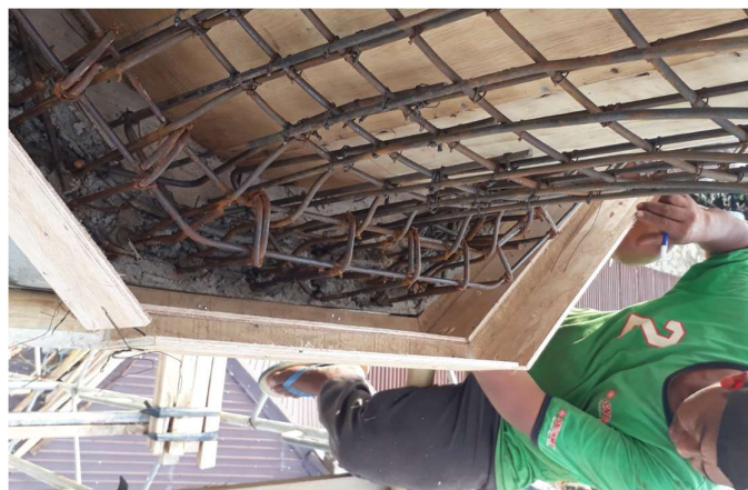
Gambar 6. Tulangan sloop dan dinding lingkaran
