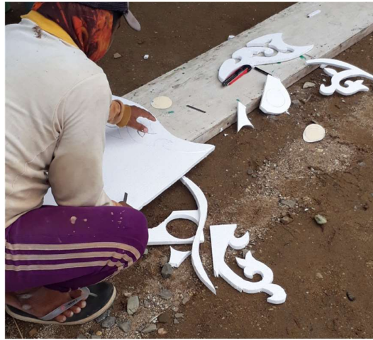
Gambar 20. Penggunaan Setroafoam untuk membentuk ukiran timbul
