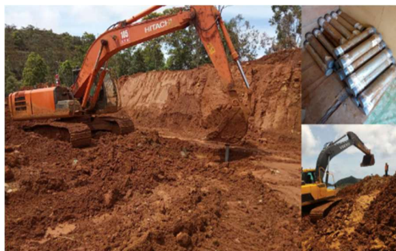
Gambar 3 Shelby Tube Sampling di Tambang Nikel
