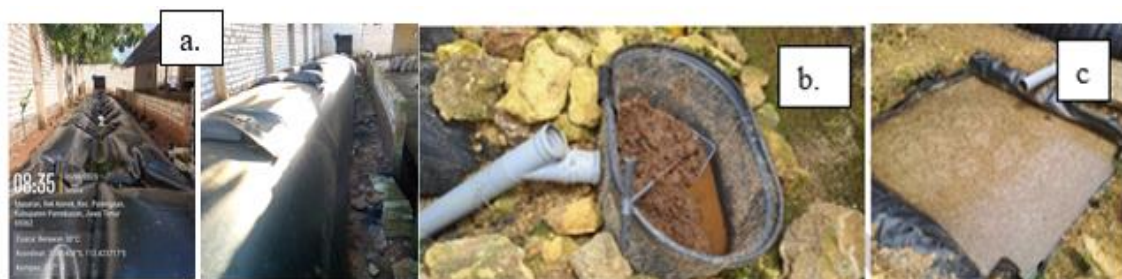
Gambar 1. a. Biogas Sistema 40; b. Inlet untuk Kohe; c. Outlet Bioslurry
