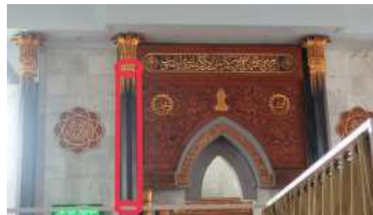
Gambar 19 Tiang Penyangga Masjid
