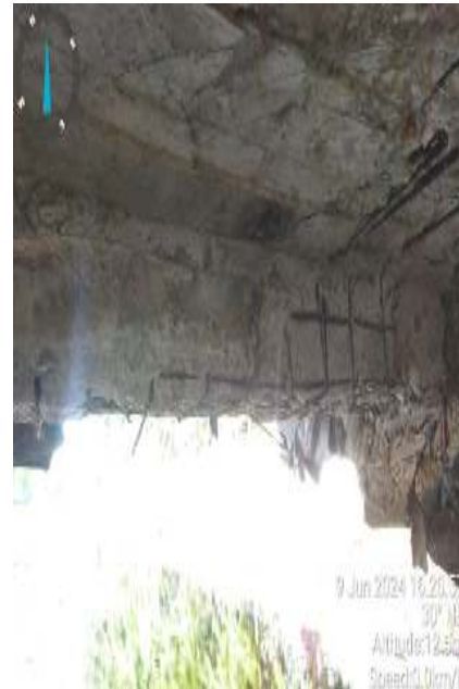
Gambar 3 Kondisi pada balok jembatan Sumber : (Dokumentasi Skripsi 2024)
