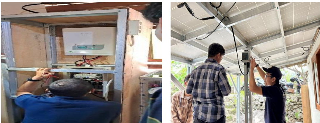
Gambar 3. Pengecekan parameter daya sistem PLTS pasca-pemeliharaan, serta edukasi pemeliharaan mandiri kepada anggota Kelompok Batik Natural Art.
